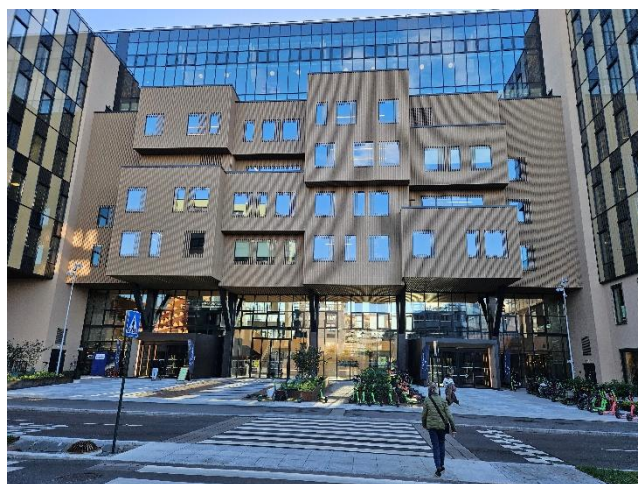
Construction City på Ulven.
