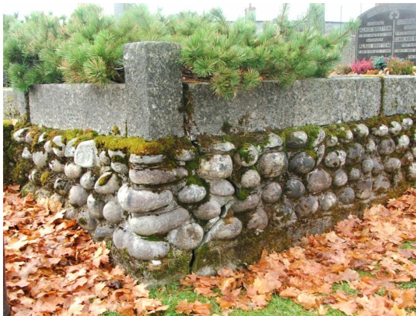
Fig. 72: Graven ligger på felt 2. Gravminne over er familiegravstedet til Brøttem. Kanten rundt gravstedet er murt opp av runde steiner. Familiegravstedet ble opprettet i 1944 (foto: Astrid Grendstad).
