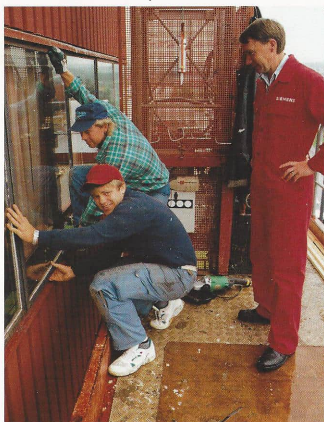
Tormod Bekken (t.h.) konstaterer at Tore Halgunset (foran) og Edvin Berg skifter vinduer raskt og effektivt.
