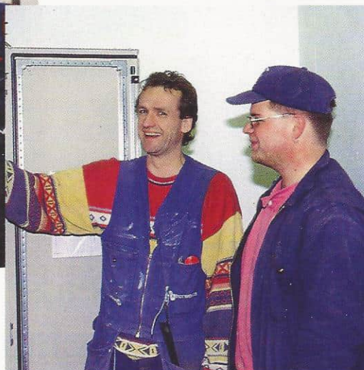
Elektroinstallasjonen i Kolstibotn Bo & Servicesenter utføres av våre montører. F.v: Audun Johnsen, Bjørn Sivertsen, Steinar Halland, Dag Øye Tvet, Svein Fjerdal, Rune Sivertsen, Kai Strømmen. Innfelt: Kai Strømmen og Steinar Halland ved en av fordelingstavlene.
