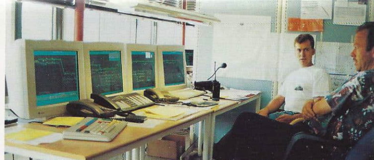
Togleder Ivar Brenden har full oversikt over trafikkbildet i kontrollrommet på toppen av elektrobygget på Lillestrøm. Herfra legger han togveier og overvåker togenes bevegelser via datatastatur. Normalt griper operatøren bare inn når det oppstår feil i og med at fjernstyringen er automatisk. (Fra Oslo S.)
