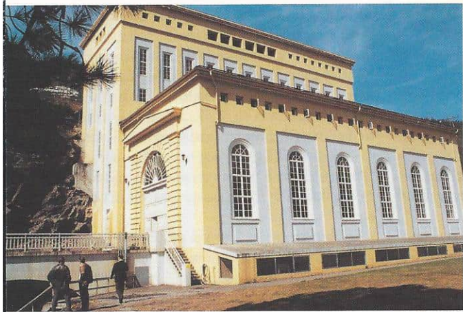
Follafooss var NTEs første kraftstasjon, satt i drift 1923. Et vakkert monumentalbygg.
