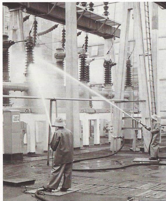
Et 120 kV-anlegg fra Siemens blir spylt under full spenning i 50-årene, en begivenhet som vakte stor oppmerksomhet i fagkretser.
