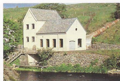
Fotland kraftstasjon 1990 (Foto utlånt av Time kommune)
