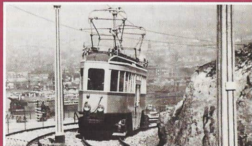
Ekebergbanen runder svingen ved Sjømannsskolen. Bildet er tatt i 1930. Vognene hadde en litt spesiell form. For at de lange vognene skulle kunne møte andre vogner på bystrekningen med det smale mellomrom man der hadde mellom skinnene, måtte endene bygges svært spisse. Vognene var derfor bare 1 meter bred i endene.
