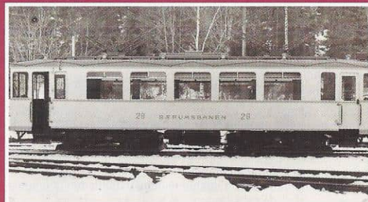
Vogn nr. 28 levert til A/S Bærumsbanen i 1926 fra Skabo. 4 stk Siemens-motorer type Dy 802, effekt 55 kW, hastighet 45 km/h.
