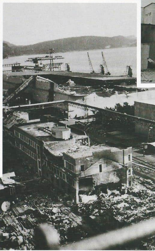
Fra ødeleggelsene på Herøya etter bombeangrepet 24 juli 1943. T.h. trafo- og koblingsstasjonen.
