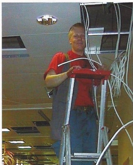
Montør Ketil Tangen trekker kabel i høyden i Sarpsborg Posthandel.
