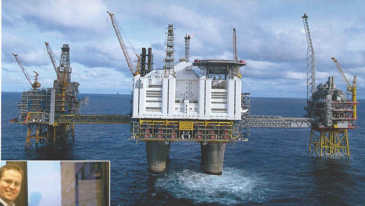
Oseberg feltsentor er det største produksjonssenteret for olje og gass i Nordsjøen. Anlegget består av Oseberg A, B og D som er bundet sammen med broer i den sørlige delen av Osebergfeltet.
