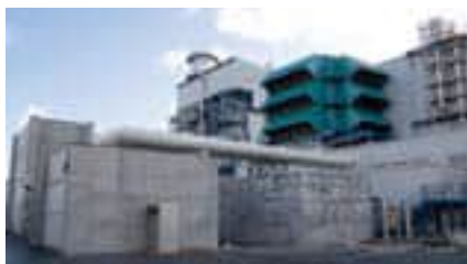
STORT ANLEGG: Fra luftinntaket på det nye gasskraftverket på Kårstø.
