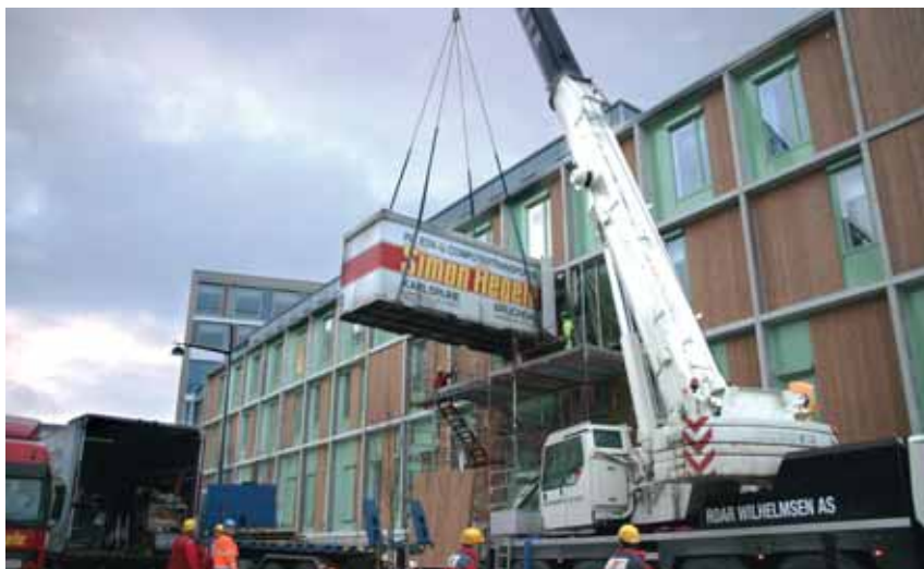
GJENNOM VEGGEN: Med imponerende presisjon ble utstyr for billediagnostikk verdt flere millioner kroner heist opp og inn gjennom store åpninger i fasaden til nye St. Olav.
