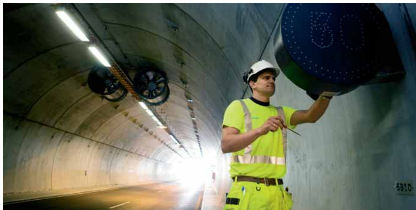
TOMISLAV KOVACEVIC I ARBEID: Siemens kommer inn i siste fase av tunnelutbyggingen, når alle kabler og tilførsler er på plass.
