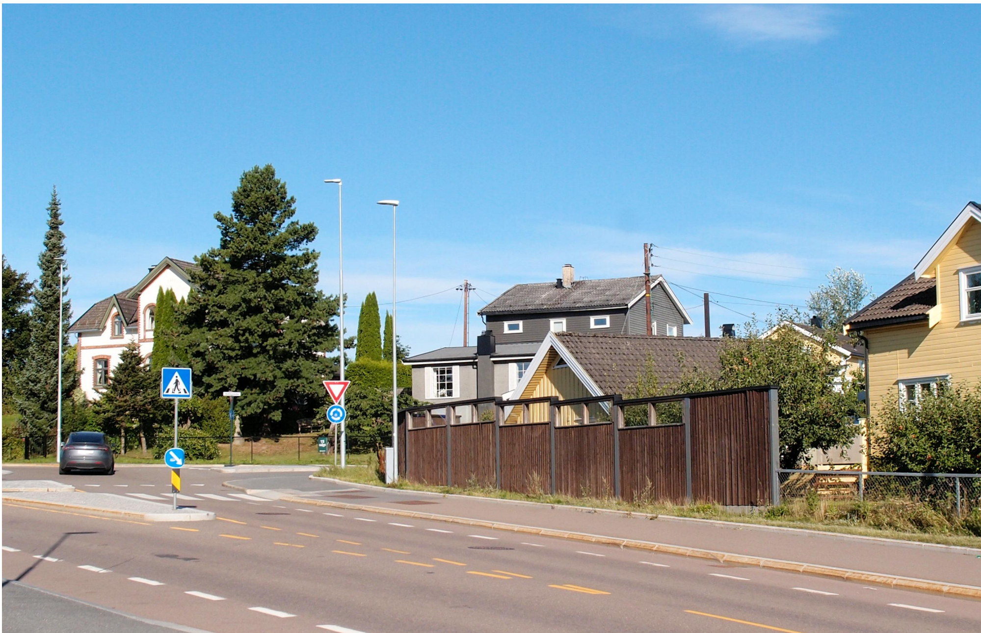
Bildet er tatt i 2025 fra omtrent samme sted og i samme retning som foregående bilde. Kippa er for lengst borte.
