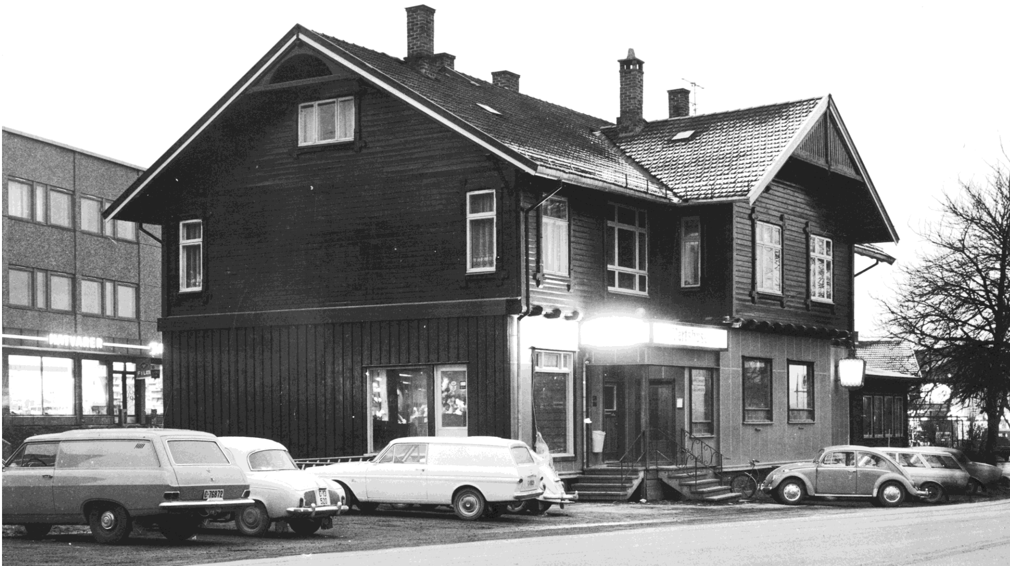
Langs Jernbaneveien – Vanaheim med med spise- og skjenkestedet Pålle i 1966.
