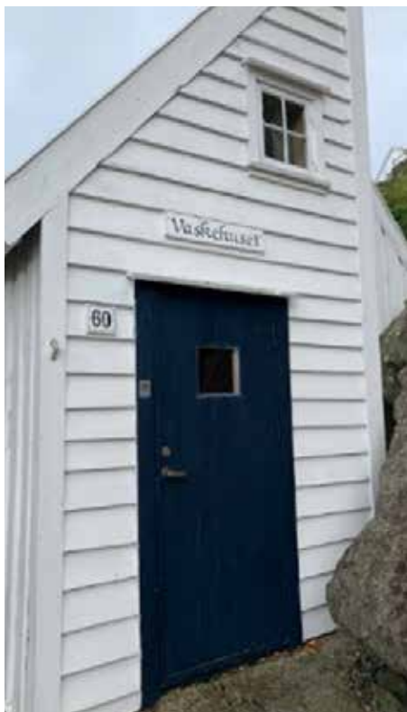
Vaskehuset ble i sin tid bygget mot fjellet. Foto: Dagny H. H. Pedersen Welle>
