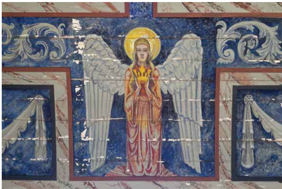
Avskallingen i takmaleriene er omfattende og godt synlige. Foto: Ingun Orderud.
