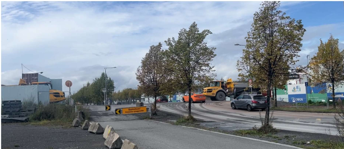
Figur 10 Anleggsdrift pågår på begge sider av kommunal vei, som er hovedadkomstvei til Oksenøya skole, barnehage og sykehjem, samt boligfelt (Oksenøya og Storøykilen). Bildet tatt retning mot Oksenøya skole.
