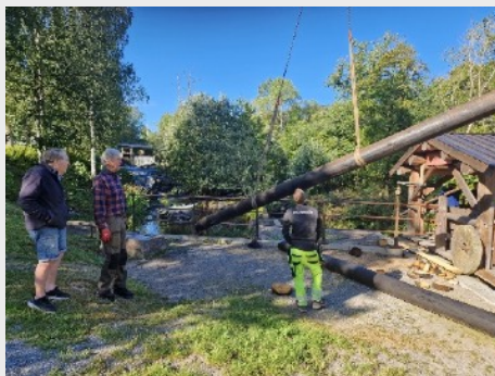
11 m lang stokk i stropper fra kranbilen til Skoveng.
