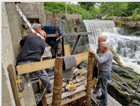
Nytt fagverk av kanaljern festes
