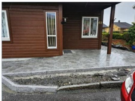
Bildet viser adkomst etter utbedring.
