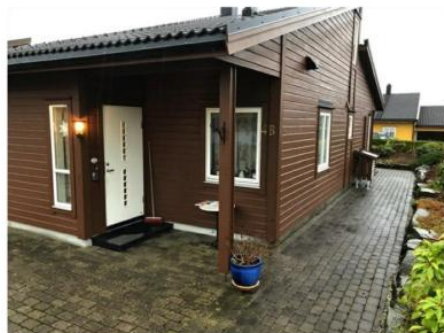
Bildet viser adkomst før utbedring.
