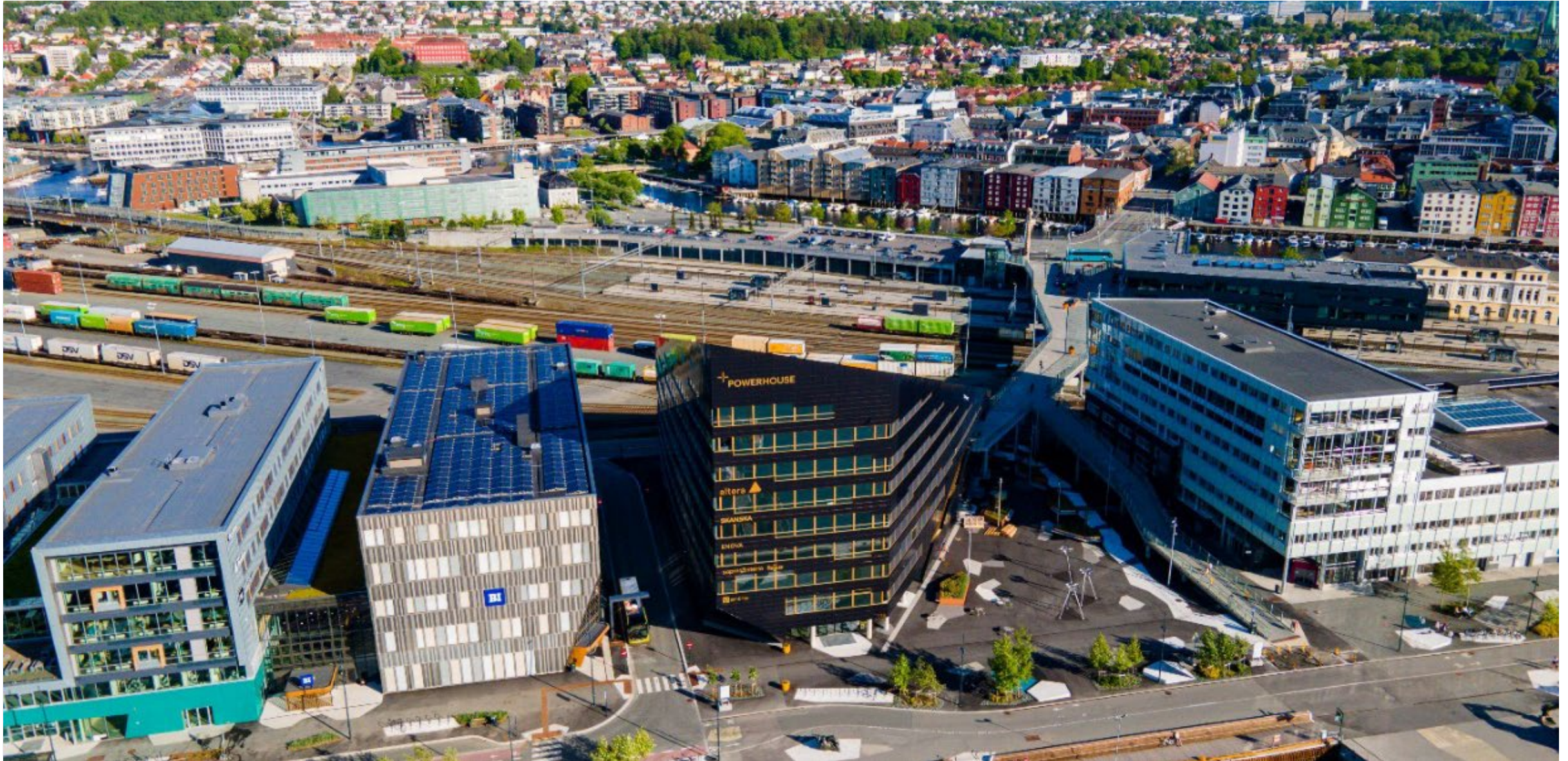
Foto: Tormod Ellingsen, viser Brattørkaia i Trondheim, kontorstedet Miljødirektoratet, Trondheim
