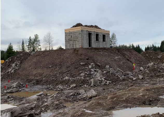
Leca bygg på 4m fylling
