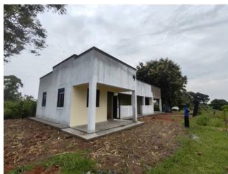
Kombinert opplærings- og lagerlokale ved Eruba (hovedprosjekt)
