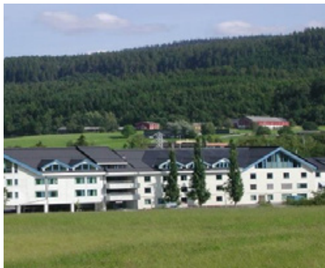
Selli rehabiliteringssenter etter utbygging.
