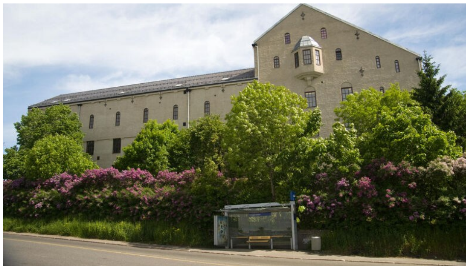
Tøyen trafo. Foto: Kulturretaten
