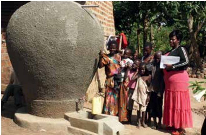
"Høsting" av vann fra tak til vanntank hos bestemødre i Kamembe
