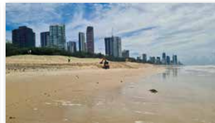
Reparasjonsarbeid på stranden i Byron Bay etter Syklonen Alfred. Det var utgravninger på mange meter, som gjorde stranden helt utilgjengelig lange stykker. Gravemaskiner måtte grave vekk kantene.
