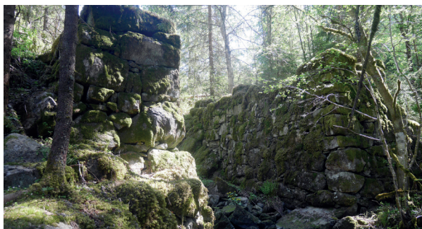
I Sagbekken står fortsatt pilarer/murvegg etter saga.
