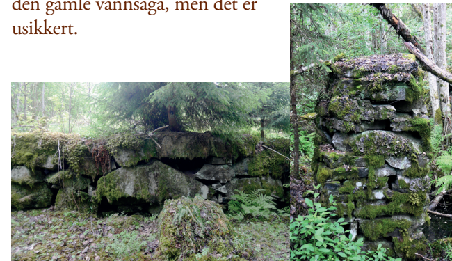
En pilar og rester av en oppbygd mur av stein er de synlige rester i dag av vannsaga ved Grønstvedt.
