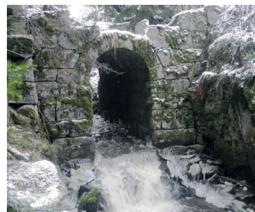
Steinhvelvsbrua / mulig demning like oppstrøms Vevelstad vannsag. Hovedveien fra Vevelstad til Oslo gikk oppe på brua. En av de flotteste steinhvelvsbruene i kommunen.
