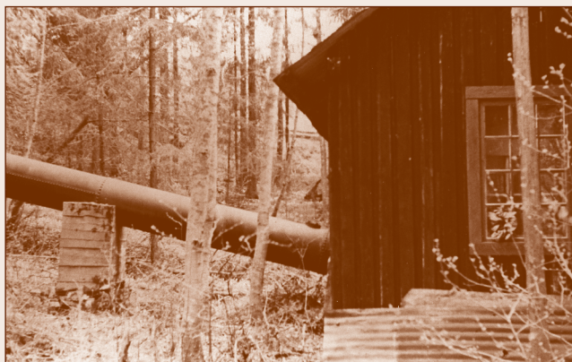
Rørgate inn til kraftstasjonen (1968).
