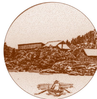
Slik så Siggerud vannsag ut fra 1900 til 1957. Fra 1530 til 1900 sto sagbruket midt i elva der høyre hus står. Vannhulet sto midt i elva hele tiden. Kraftoverføring ca. 100 m med reimer/wire opp til sagbruket etter 1900. Bygget til venstre er vedhuggeriet.
