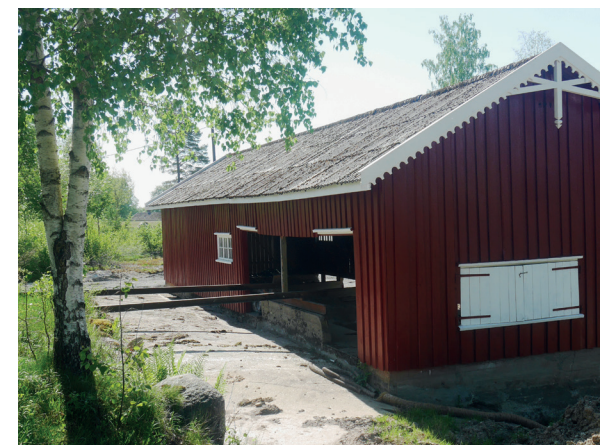
Saga står fortsatt på samme sted som den ble flyttet til i 1917.
