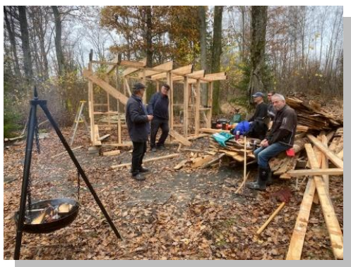
2021 Bygging av gapahuk
