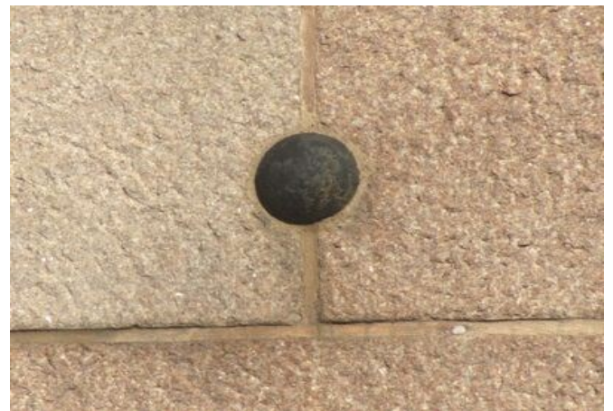
Kanonkule innmontert i veggen Dronningens gate 15, det gamle Hovedpostkontoret.
