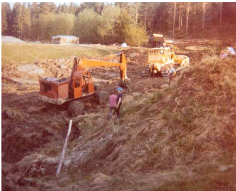
Fra et bløtt område langs Monsrudveien. Åge Monsruds gravemaskin måtte vinsjes ut av gjørma. Nærmest kamera står Lars Håkon Stykket(12) og Per Stykket, helt til høyre Ingunn Stykket. Mannen i midten er antagelig føreren av bulldoseren. 1981. Foto: Lars Stykket
