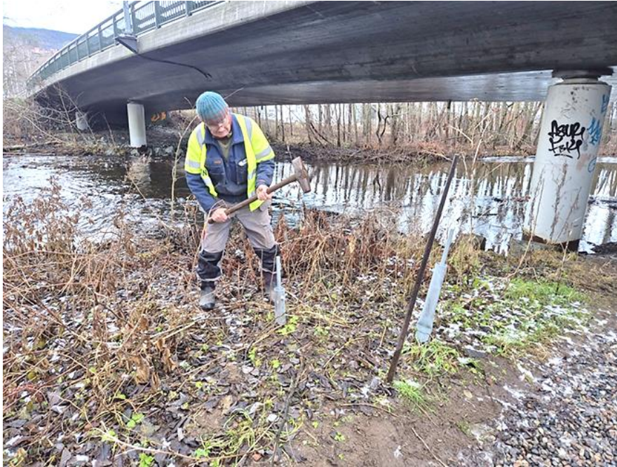
Jordspyd til skilt under oppsetting 2024
