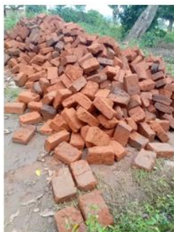
Bidrag til ny latrine fra lokalbefolkningen
