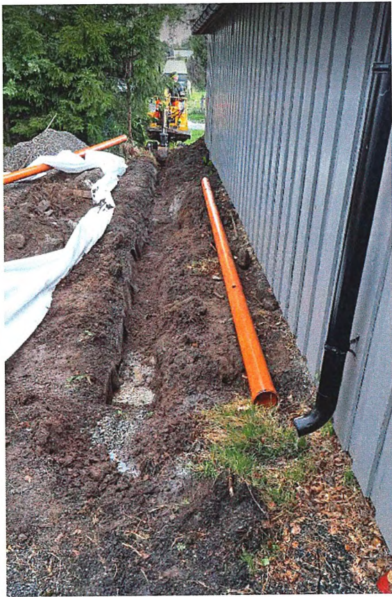
Det ble gravd grøft ut mot fellesarealet og dreneringsrør ble lagt ned.
